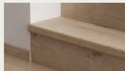
NOSEK SCHODOWY, ZLICOWANY Do tworzenia zlicowanych powierzchni na stopniach schodowych.
